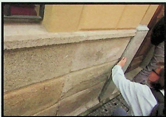
Foto 2 - Escamação do Granito Itaquera na base da Casa da Imagem de São Paulo.
