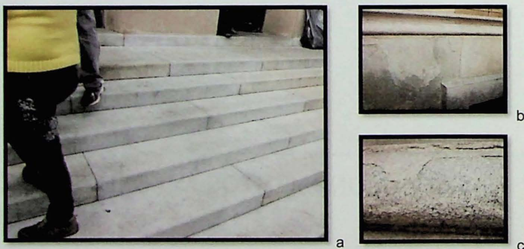
Foto 1 - Secretaria da Justiça. a) Escadaria em Granito Itaquera. b) Parte da fundação do prédio com escamação. c) Acabamentos com escamação.
